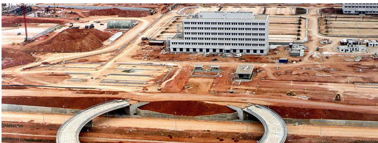
Εικόνα 1 Εργοτάξιο αεροδρομίου Ελ. Βενιζέλος, πηγή (διαΝΕΟσις, 2016).
