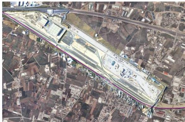
Εικόνα 4.1 Αεροφωτογραφία Θριασίου Πεδίου κατά την περίοδο εκτέλεσης των πρώτων εργασιών υποδομής, ΓΑΙΑΟΣΕ 2018
