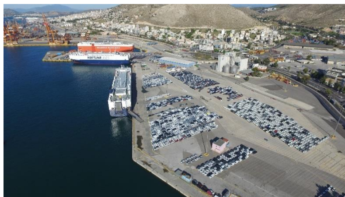
Εικόνα 3.4 Σταθμός διαχείρισης οχημάτων Γ2
