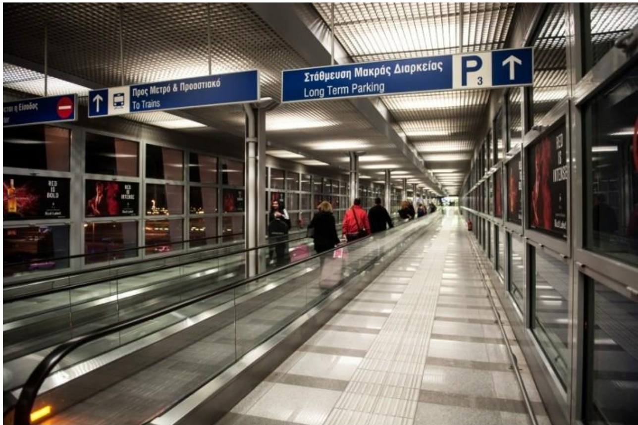
(6) Η πεζογέφυρα που ενώνει το Μετρό, Προαστιακό με το αεροδρόμιο Πηγή : https://www.athenstransport.com/airport/
