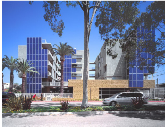
Εικόνα 2.8: Το κτηριακό συγκρότημα «Colorado Court» στη Santa Monica της Καλιφόρνιας (McGrath, 2012)
