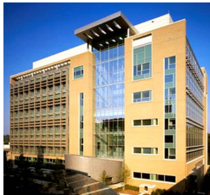
Εικόνα 2.2: Το κτήριο «CDC Division of Laboratory Sciences, Building 110» στην Ατλάντα της Γεωργίας (McGrath, 2012)
