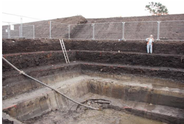
Εικ. 3.9. Σκάμμα με τη μέθοδο των κλιμακωτών τομών 519
