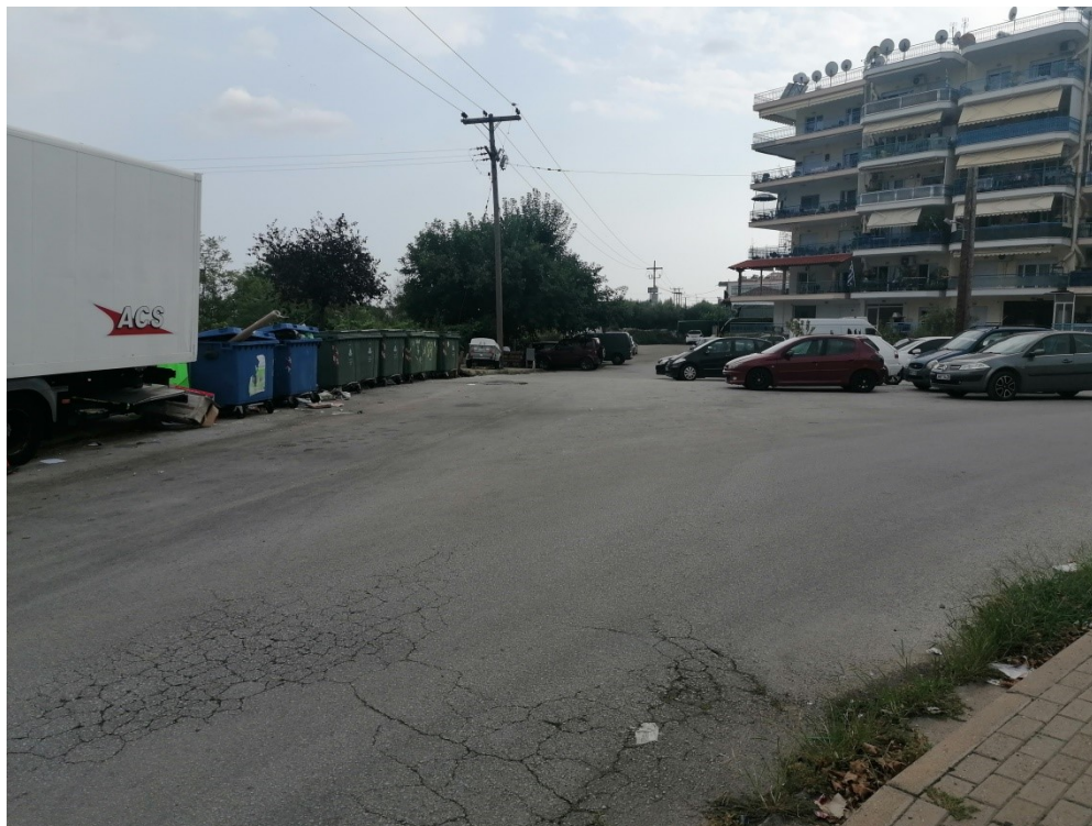
Εικόνα 104: Κοινόχρηστος χώρος Στάθμευσης Πολυκατοικιών (Πάροδος Μιαούλη)
