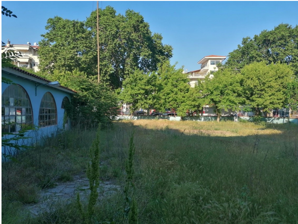
Εικόνα 74: Ά Βρεφικός Σταθμός (Πλέον κλειστός)
