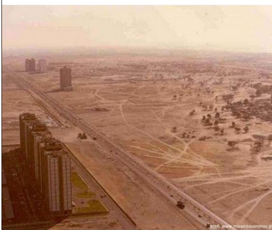
Εικόνα 55. Ντουμπάι 1990, πηγή: www.mixanixronou.gr
