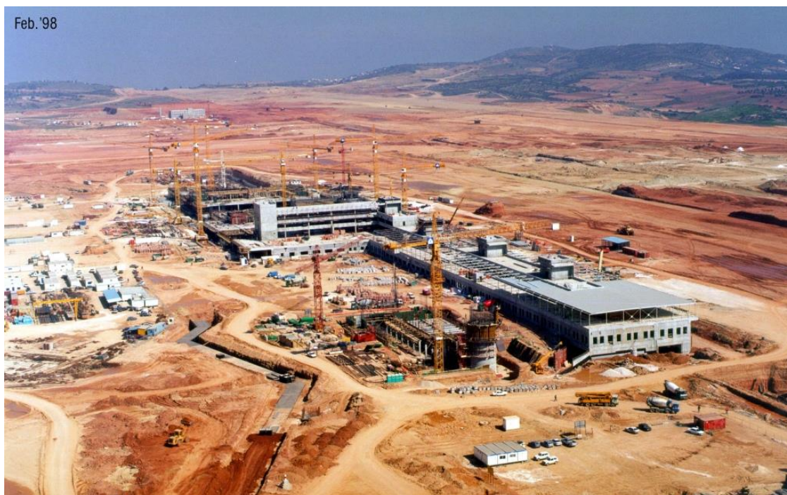
Εικόνα 15: Κατασκευή αεροδρομίου, Φεβρουάριος 1998
