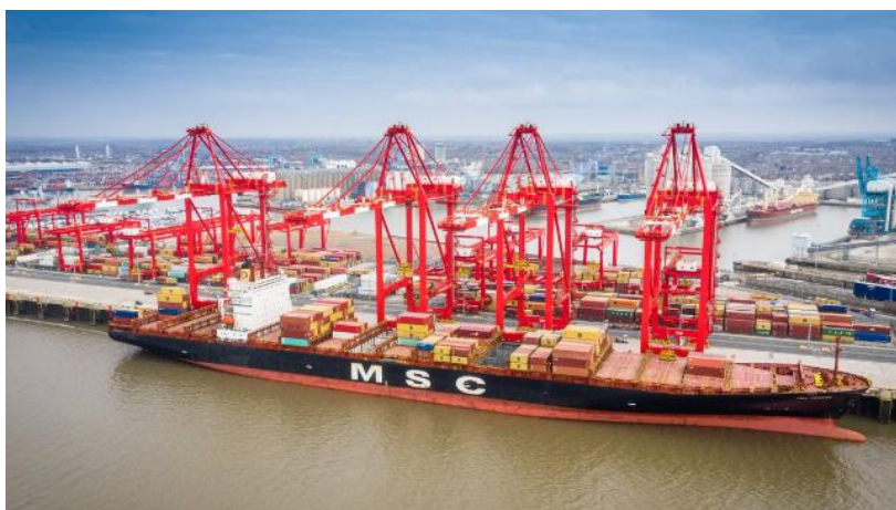
Εικόνα 4.6: Γερανογέφυρες στο λιμάνι του Λίβερπουλ.
