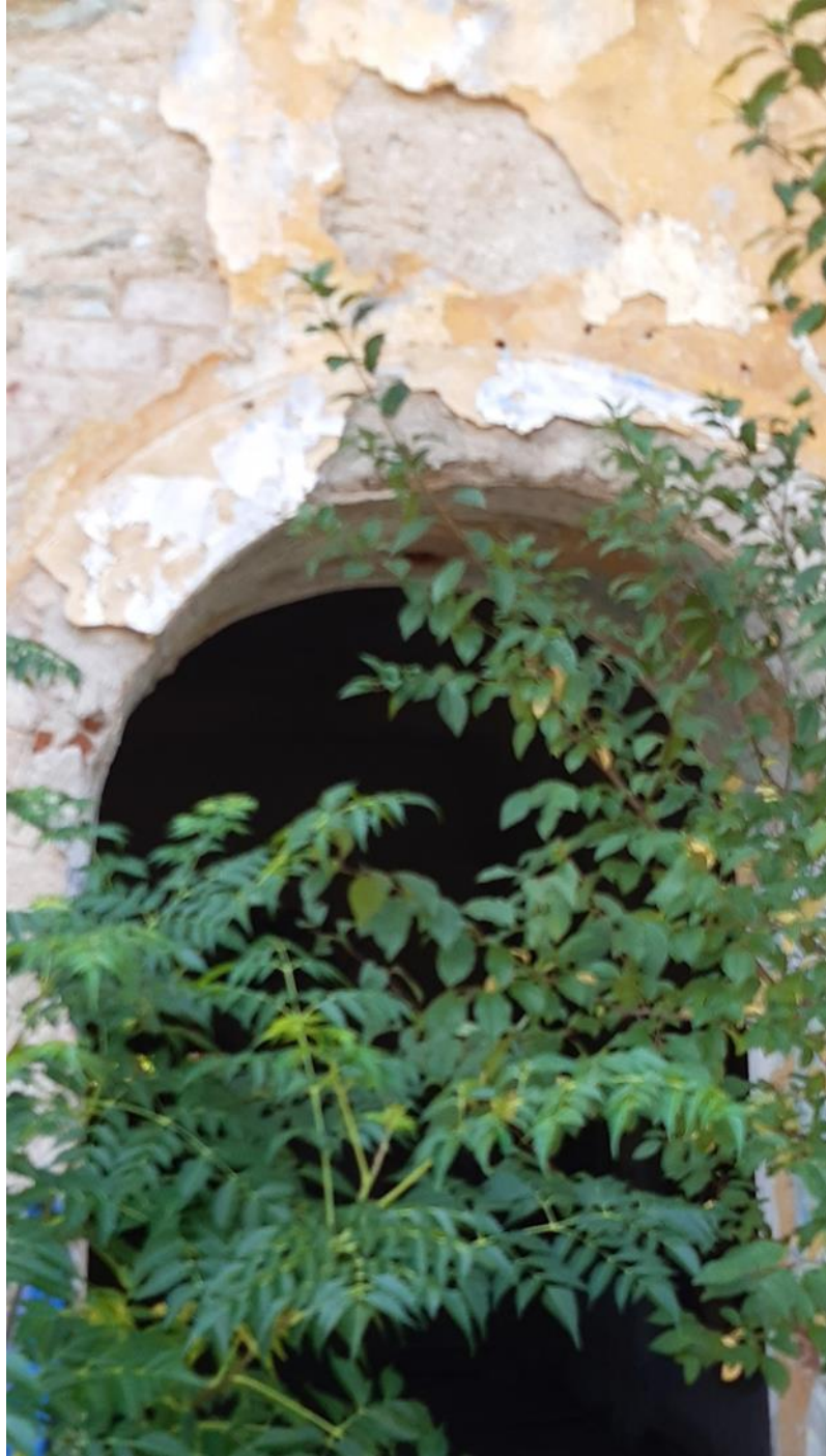
Εικόνα 49: Παλιό Φρέσκο. Οπτική κτηρίου με παράθυρο. Φωτ. ερευνήτριας, Στρατόπεδο Παύλου Μελά, Θεσσαλονίκη 2020
