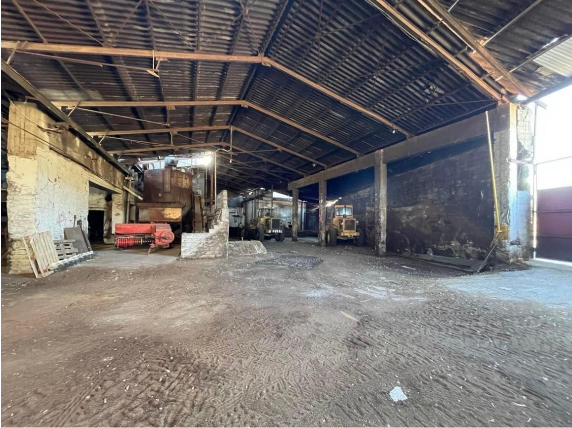
Εικόνα 8: Φωτογραφία από το εσωτερικό του πυρηνελαιουργείου. Στα αριστερά φαίνεται το υφιστάμενο ξηραντήριο, ενώ στα δεξιά θα τοποθετηθεί το νέο ξηραντήριο.
