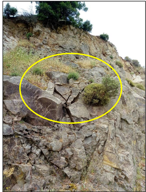
Εικόνα 35 Διάρρηξη επί πρανούς
