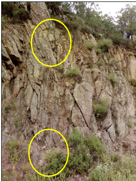
Εικόνα 36 Αποκόλληση τεμαχίων, καταπλάκωση φυτών
