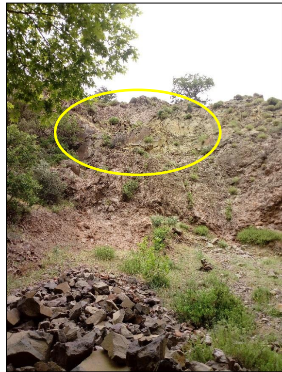
Εικόνα 33 Διαρρήξεις στην κορυφή του πρανούς
