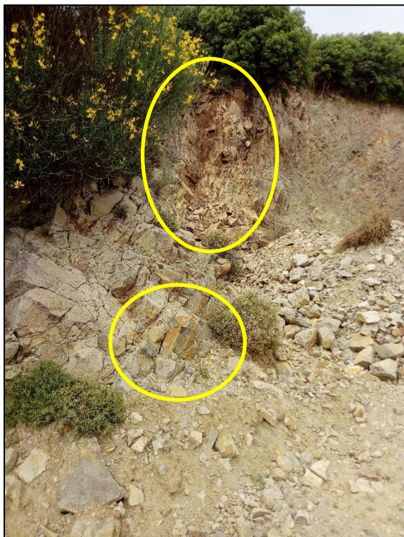
Εικόνα 38 Γραμμική εμφάνιση διάρρηξης και καταπτώσεων (Λατομείο)
