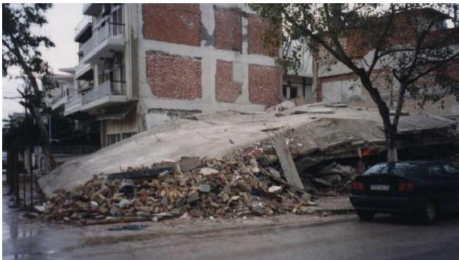
Εικόνα 6. 12 Απεικόνιση κατάρρευσης κτίσματος κατοικίας, παλαιάς κατασκευής, στην επίκεντρη περιοχή του Μενιδίου
