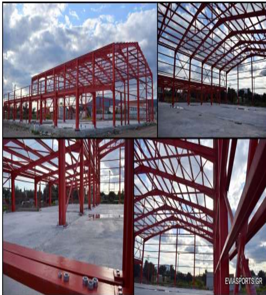
Εικόνα 3: Φωτογραφίες από την κατασκευή του κλειστού γυμναστηρίου
