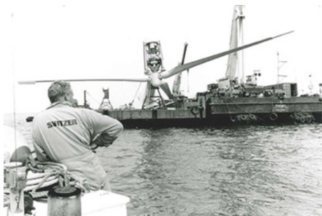
Εικόνα 2: Κατασκευή Υπεράκτιου Αιολικού Πάρκου Δανίας 1991
