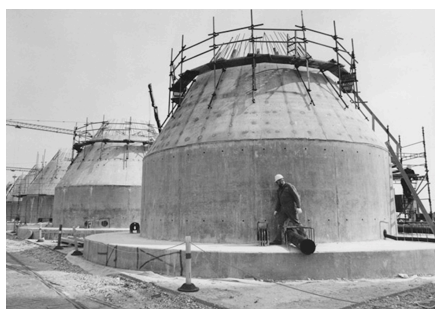
Εικόνα 3: Κατασκευή Θεμελίων για το Υπεράκτιο Αιολικό Πάρκο Δανίας
