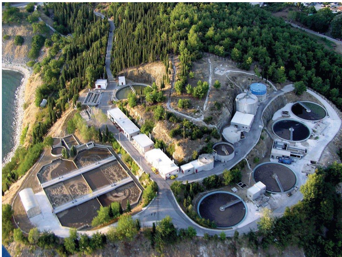
Εικόνα 2. Εγκατάσταση Επεξεργασίας Λυμάτων Καβάλας (ΕΓΥ)
