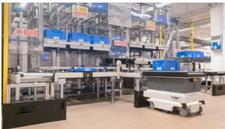
Εικόνα 5.12 Οι σταθμοί εργασίας με σύστημα pick-to-light και διεπαφή MR
