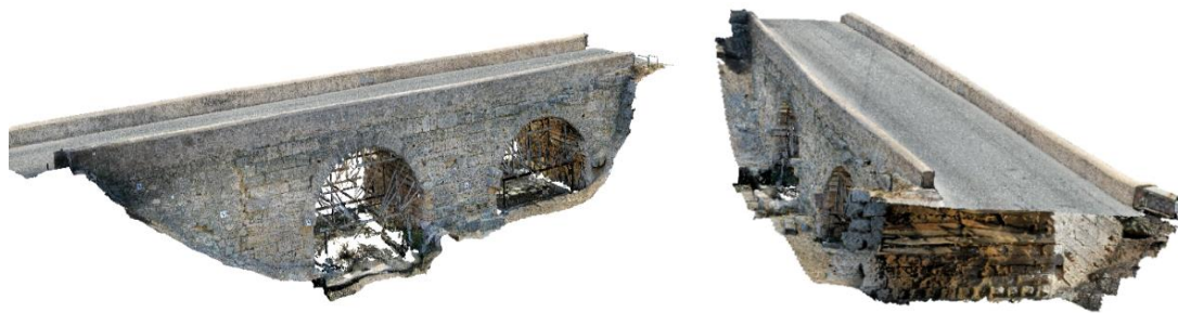
Εικόνα 4.7: Το τρισδιάστατο μοντέλο της ρωμαϊκής γέφυρας από το λογισμικό Agisoft Metashape Professional.
