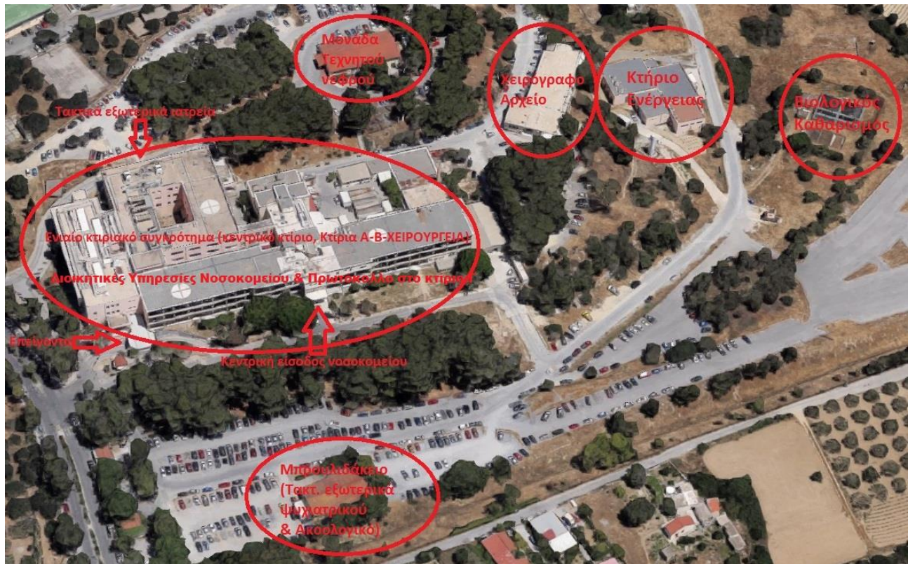
6. Προβολή Συγκροτήματος Βενιζελείου Νοσοκομείου
