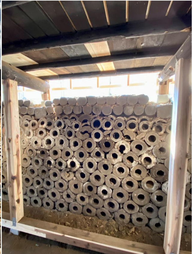
Εικ. 38. (αριστερά) Αστοχίες της παραγωγής συσσωρευμένες έξω από τον αναρριχώμενο φούρνο noborigama του Kuno Toen. Φωτό: Δ.Ζ. Εικ. 39. (δεξιά) Κεραμικά δοχεία γυτανβο, που χρησιμοποιούνται για να κρατούν θερμότητα το βράδυ, ως δομικά υλικά σε τείχος στο Kuno Toen. Φωτό: Δ.Ζ.
