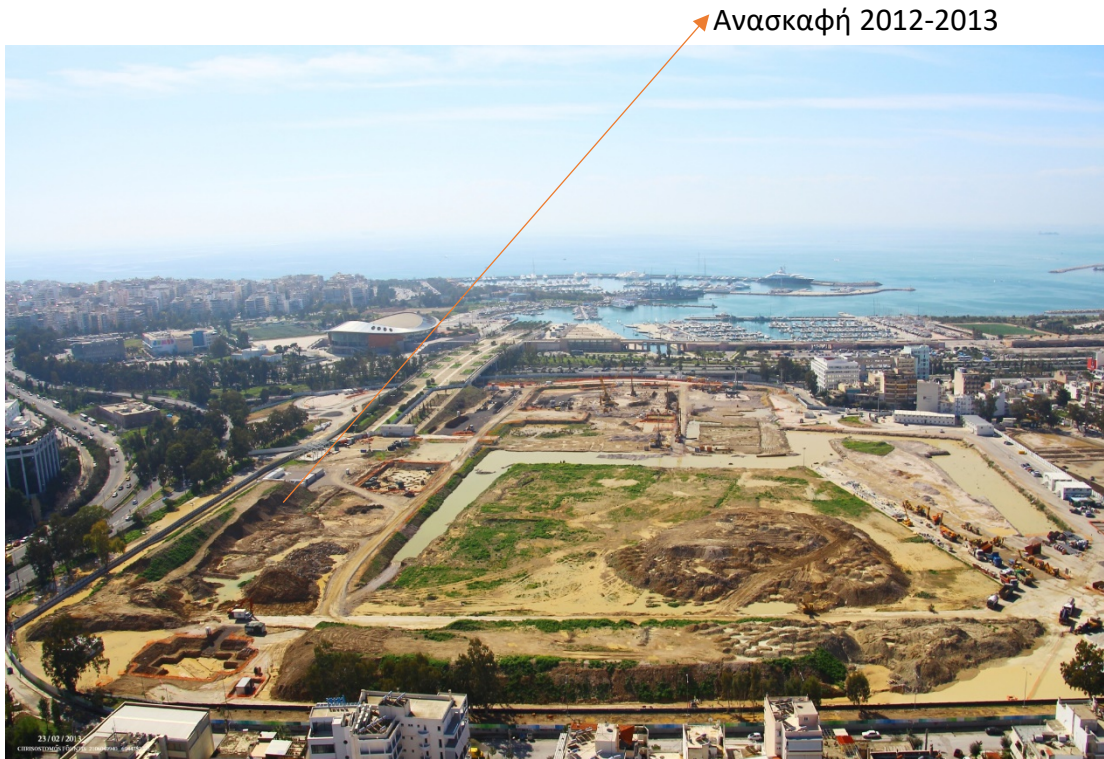
Εικ. 1. Κέντρο Πολιτισμού Στ. Νιάρχος (υπό κατασκευή, καλοκαίρι 2013) (Αρχείο ΕΦΑΠΝ)
