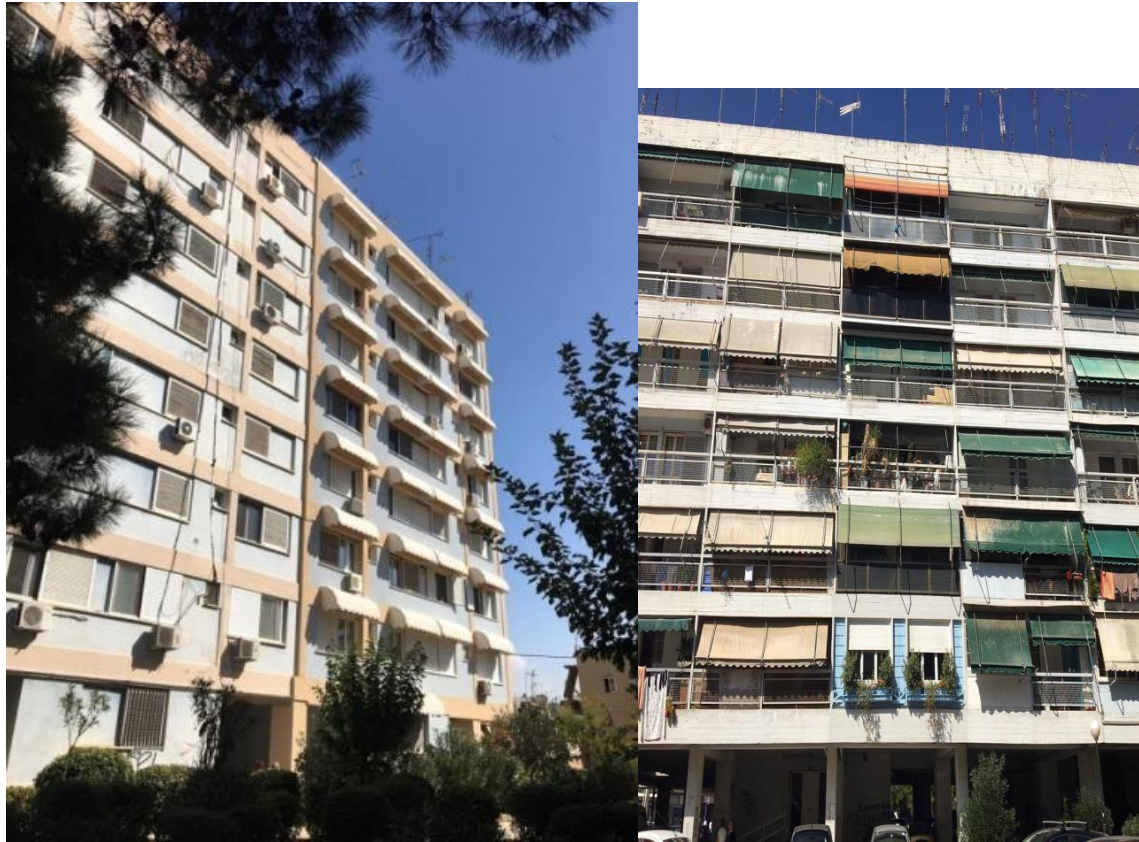
Εικόνα 5.4 και 5.5 Συγκρότημα εργατικών κατοικιών κοντά στο σταθμό του μετρό Περιστέρι Πηγή: εικόνες από διαδίκτυο
