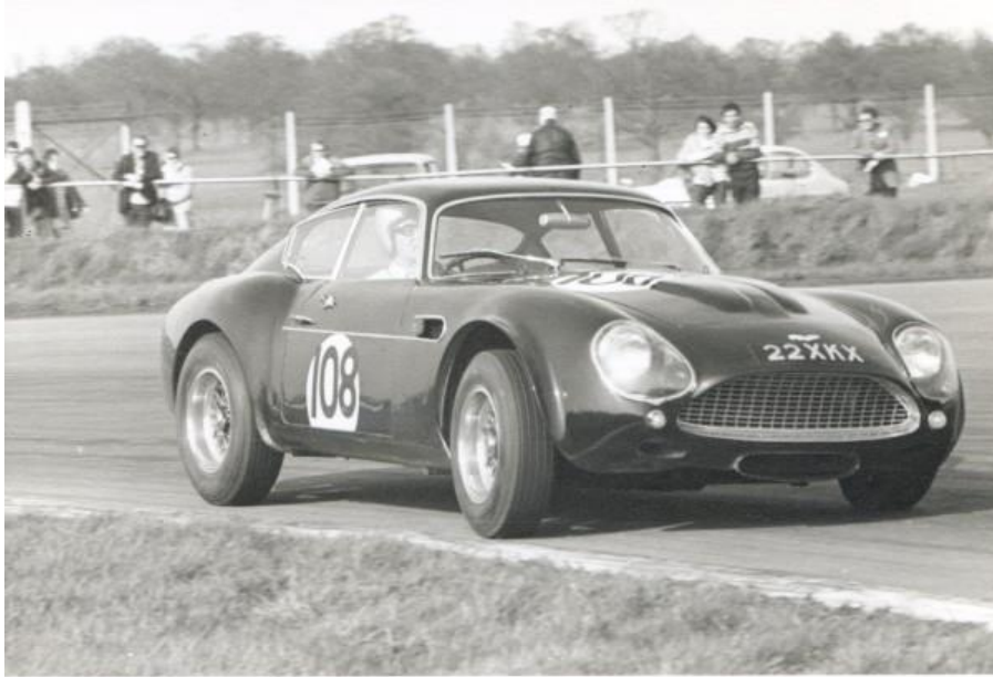
Εικόνα 3.3 : Η Aston Martin DB4 GT Zagato με αριθμό σασί 0200/R με τις μετατροπές που ακολούθησαν αργότερα από τρίτους, όπως το αρκετά φαρδύτερο πίσω και εμπρός φτερό και το διαφορετικό καπό.
