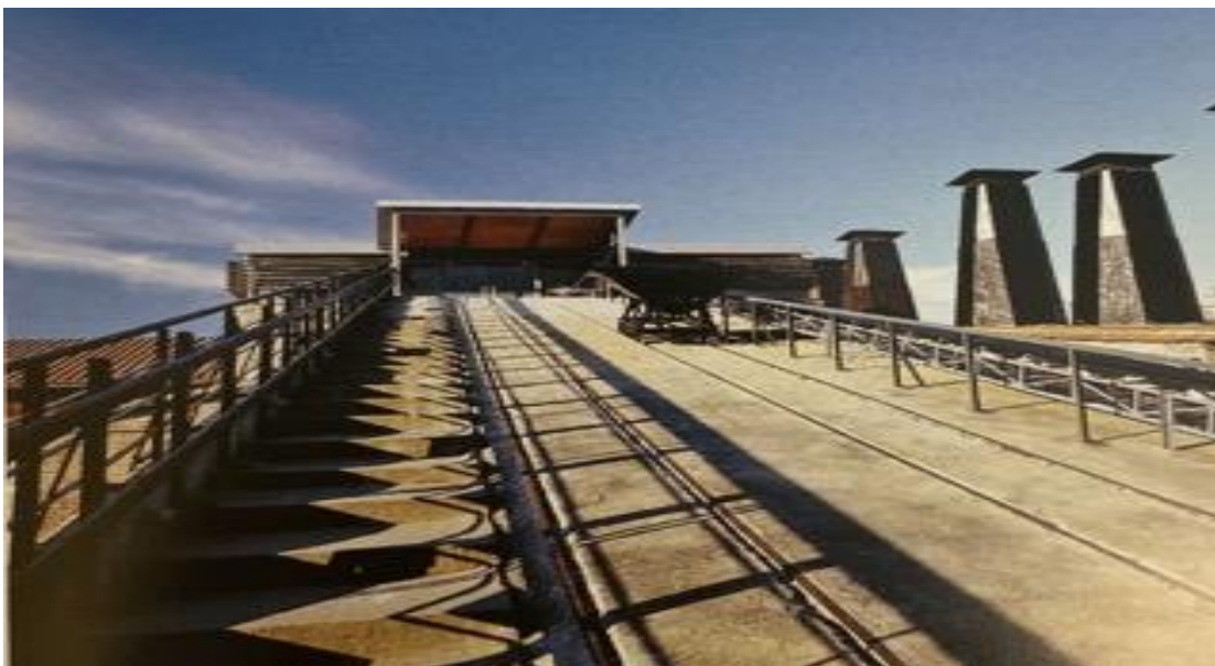
Εικόνα 40 Το πατάρι του μύλου στο ύψωμα, με την ράμπα και το βαγόνι μεταφοράς του αργίλου
