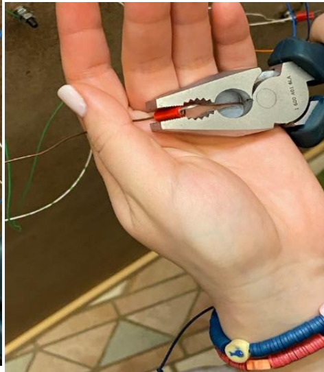
Εικόνα 85 Διαδικασία εφαρμογής των ακροδεκτών στο τελείωμα του καλωδίου
