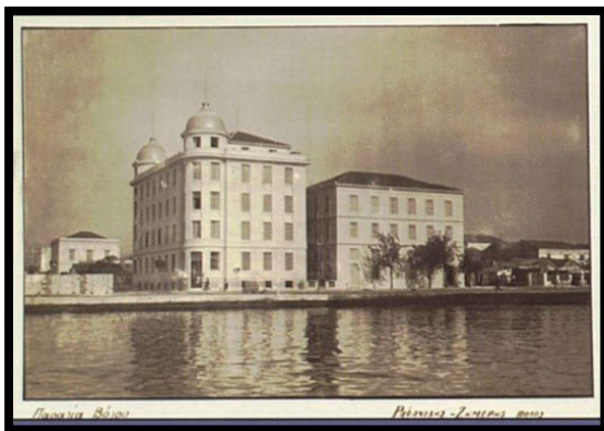
Εικόνα 5 Το κτίριο Παπαστράτος 1930
