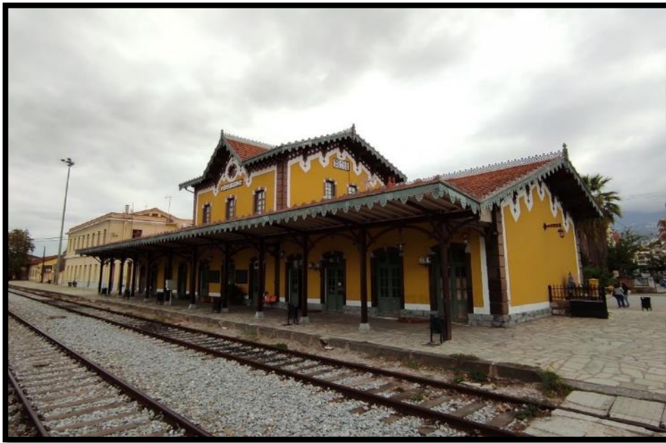
Εικόνα 6 Το κτίριο του σταθμού ΟΣΕ
