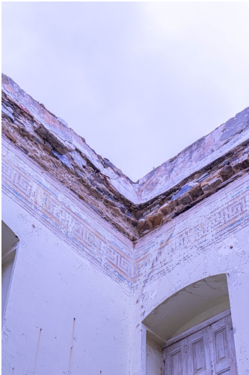
Εικ.60: Πεσμένη οροφή κτηρίου επί της οδού Ύδρας, Ερμούπολη | Προσωπικό αρχείο Εικ.61: Παράδειγμα κατάρρευσης στέγης και ξυλόπηκτης τοιχοποιίας (τσατμάς) | Προσωπικό αρχείο
