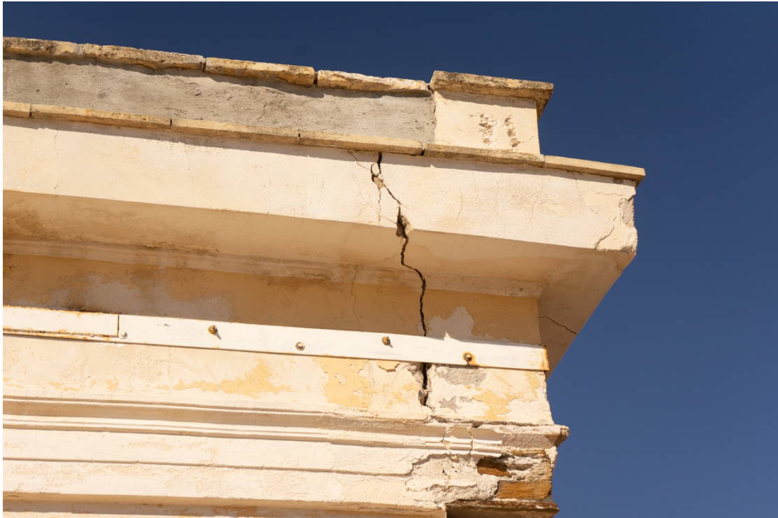
Εικ.22: Σύστημα μεταλλικής περίσφυξης πύργου του Δημαρχείου Ερμούπολης.
