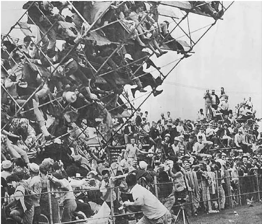
Εικ.1: Υποχώρηση μεταλλικού ικριώματος τη δεκαετία του 60 στην Πίστα της Ιντιανάπολις, με 2 θανάτους και 50 τραυματισμούς.
