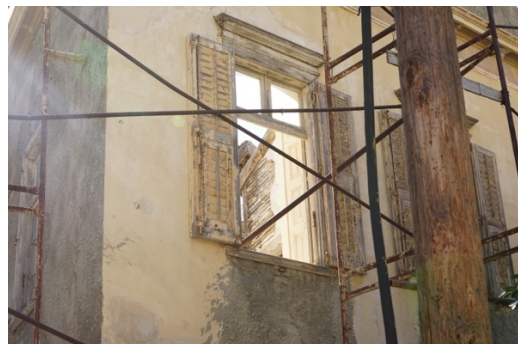
Εικ.16: Παράδειγμα πρόχειρων εντατήρων από σίδηρο και ξύλινες δοκούς
