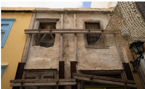
Εικ.16: Παράδειγμα πρόχειρων εντατήρων από σίδηρο και ξύλινες δοκούς
