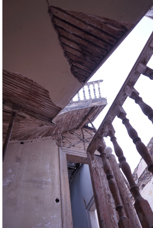
Εικ.60: Πεσμένη οροφή κτηρίου επί της οδού Ύδρας, Ερμούπολη | Προσωπικό αρχείο Εικ.61: Παράδειγμα κατάρρευσης στέγης και ξυλόπηκτης τοιχοποιίας (τσατμάς) | Προσωπικό αρχείο
