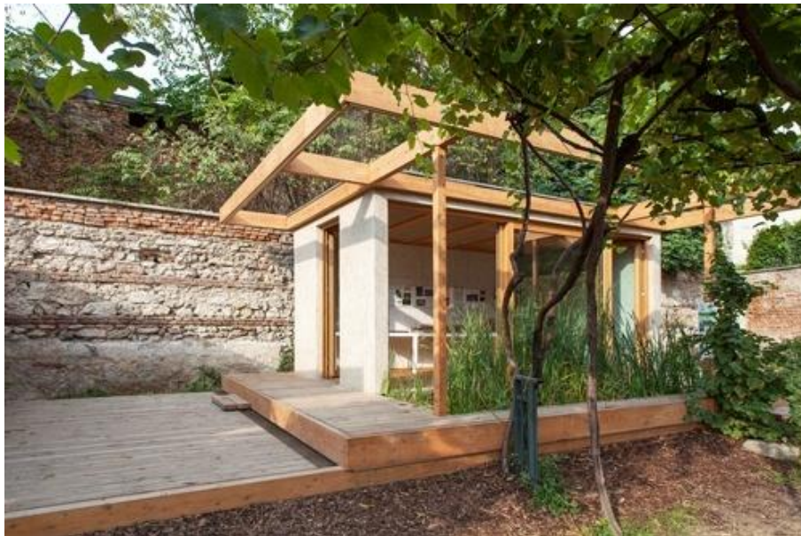
Εικ 55 Tygha house στην έκθεση EXPO 2015 στο Μιλάνο (TYGHABOARD)
