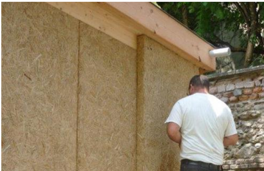
Εικ 57 Typha house στην έκθεση EXPO2015 Μιλάνο: Διαδικασία τοποθέτησης πάνελ typhaboard (TYPHABOARD)
