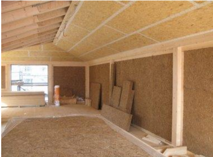
Εικ 54 Ο ξύλινος σκελετός της κατασκευής και τα πάνελ tygha board
