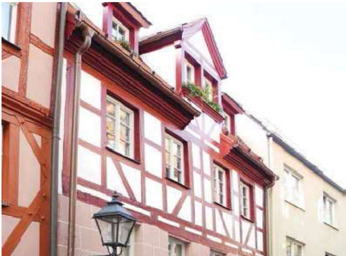
Εικ 49 Εξωτερική εμφάνιση του κτιρίου μετά την αποκατάσταση (Krus, Theuerkorn, Großkinsky, & Künzel, 2014)
