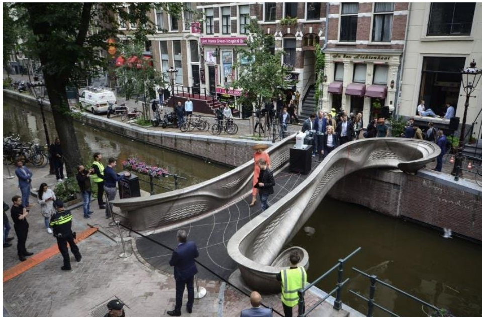
Εικόνα 2. 6 Ατσάλινη γέφυρα κατασκευασμένη με προσθετική κατασκευή [18]
