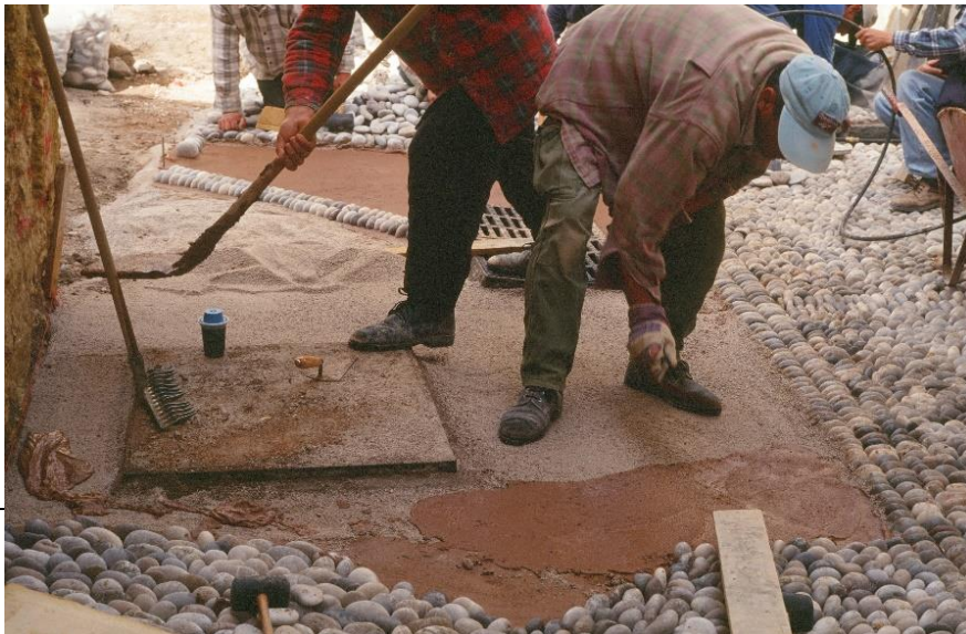
Κατασκευή βοτσαλωτού δρόμου στη Μεσαιωνική Πόλη Ρόδου (αρχείο Πάρη Παπαθεοδώρου)
