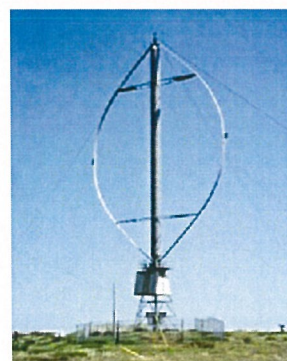
Σχήμα 1-4: Ανεμογεννήτρια Darrieus (Πηγή: Μαρούδας, 2008)
