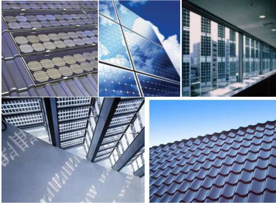
Εικόνα 99 Εφαρμογές φωτοβολταϊκών στοιχείων σε κτίρια
