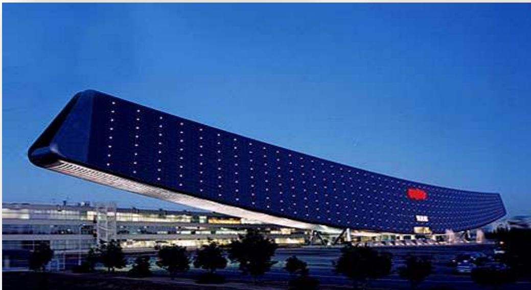
Εικόνα 70 Αριστερά: Η ένταξη των φωτοβολταϊκών κυττάρων σε ένα κτίριο στο κέντρο Thoreau για τη βιώσιμη ανάπτυξη (Energy point, το περιοδικό για την ενέργεια, 2010) Δεξιά: «Φωτοβολταϊκή Πέργκολα», Βαρκελώνη ( www.germancarforum.com ) Κάτω: Sanyo Solar Ark, Gifu, Japan ( sanyo.com/solarark )
