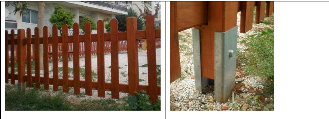
Εικόνα 10.1: Φωτογραφίες από το φράχτη περίφραξης για παιδότοπο. Λεπτομέρεια του σημείου στήριξης.
